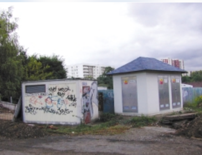
Stará a nová trafostanice
