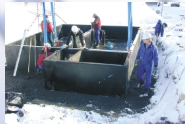
Usazování základových van
