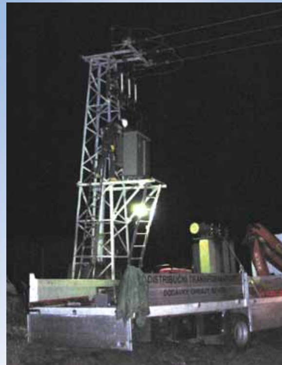
Výměna transformátoru - noční foto
