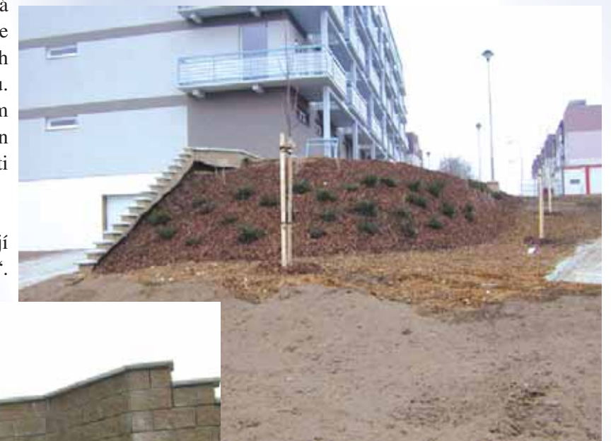
Boční pohled - terénní úpravy
