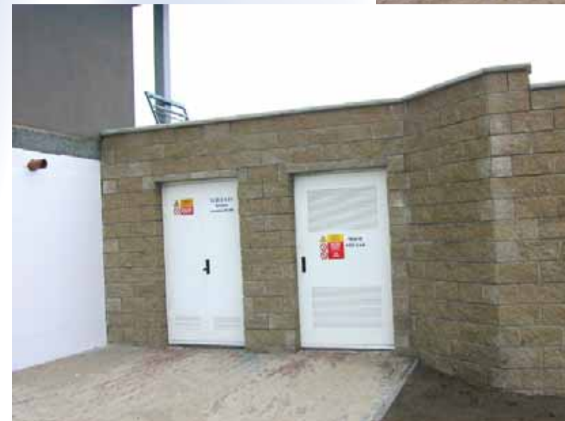
Vstup do trafostanice
