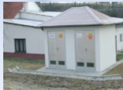
U HRBITOVA - PET® 350 Valbová střecha - kanadský šindel rozv. vn - PS 24/1, rozv. nn - RDO 1000, transformátor 400kVA postaveno 9/1999
